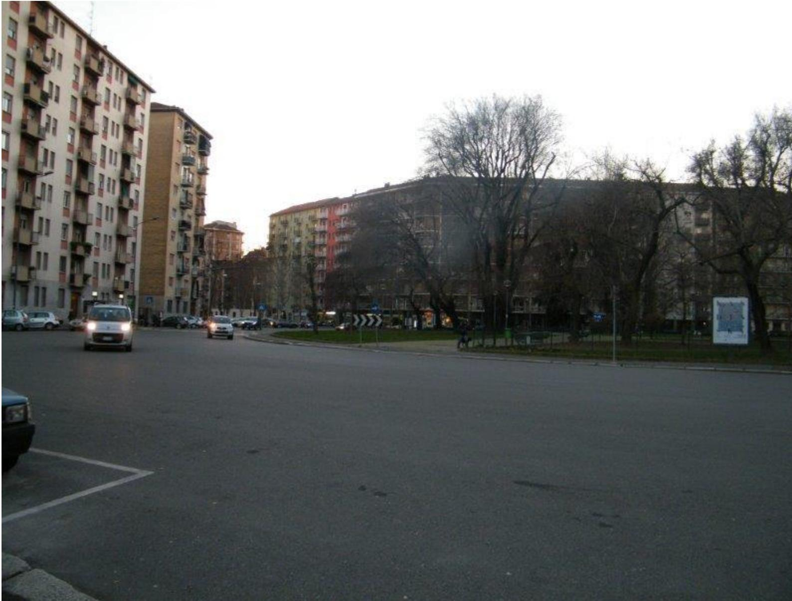
**Fotografia n.° 1: il sovradimensionato spazio di manovra della rotatoria**
