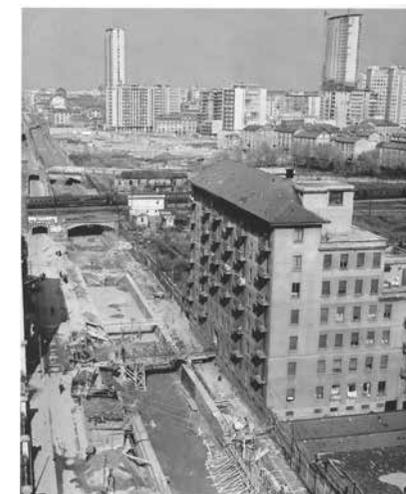
Fig. 30 il canale interrato della Martesana
