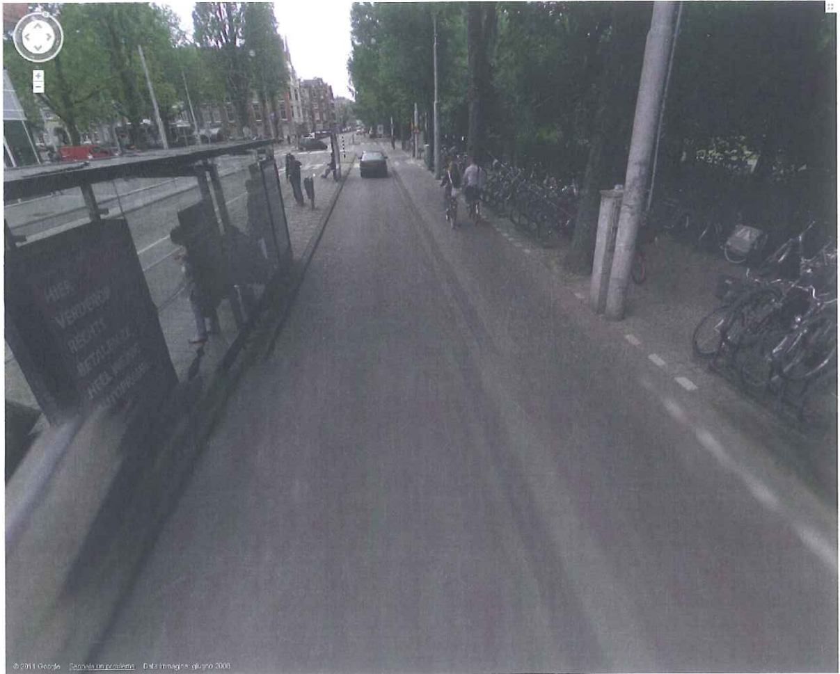
2)Amsterdam, Osterpark, margine Ovest, tratto meridionale..In questo caso la pista ciclabile è in struttura
