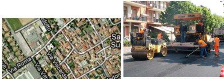
MANTO STRADALE AREA VIA PIAVE
