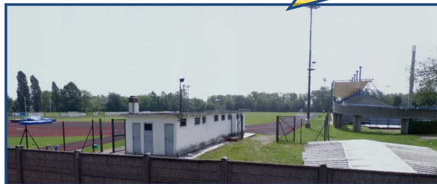
MANUTENZIONE CENTRO SPORTIVO "S.PERTINI"
