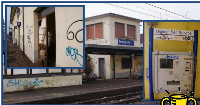
MANUTENZIONE STAZIONE FS
