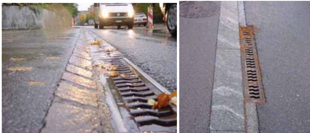
Esempio di trattamento dei bordi: particolare attenzione è stata posta all’inserimento delle scoline e nell’altezza ridotta del marciapiede (Berna – Foto Polinomia)
