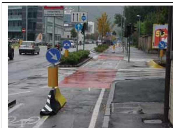
Esempio di continuazione della pista attraverso l'intersezione, realizzata con una banda colorata (Bolzano)
