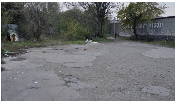
15 novembre 2016 - termine della Via Guido da Velate
