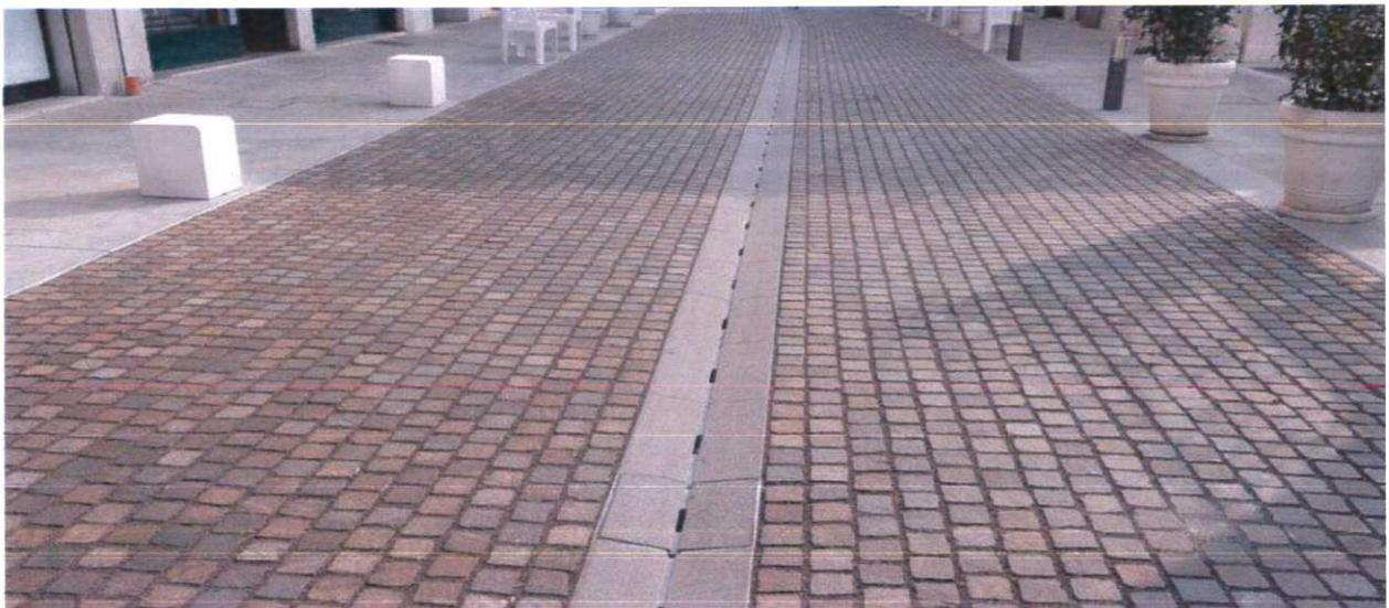
Per tutte le superfici pavimentate (percorsi pedonali e area gioco per bambini) si prevede un sottofondo costituito da mista di ghiaia e sabbia, sormontato da un massetto in calcestruzzo armato con rete elettrosaldata.
